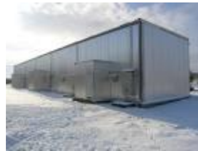
Sala de control de ubicación remoto típica de minas
