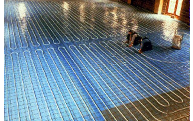
INSTALACION DE TUBERIAS BAJO PISO PARA SISTEMA DE LOSA RADIANTE
