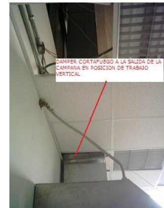
Campana de pared suministrada e instalada por JC SOLUCIONES TECNICAS SAC, a la izquierda montaje de la campana aun sin ductos, en la foto de la derecha campana con ductos y damper cortafuego (ver flecha)
