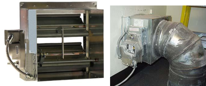
Damper para humos y su montaje en un ducto
